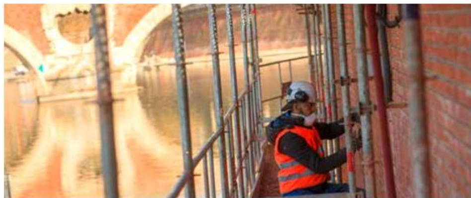
Chantier quais Saget © P.Nin
